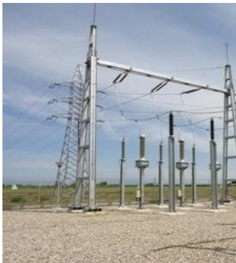
Figura 32 - Estruturas do pórtico
