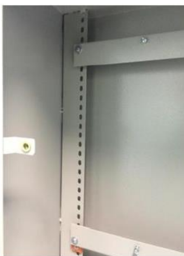
Figura 2: Detalhe da longarina e aplicação dos isoladores
