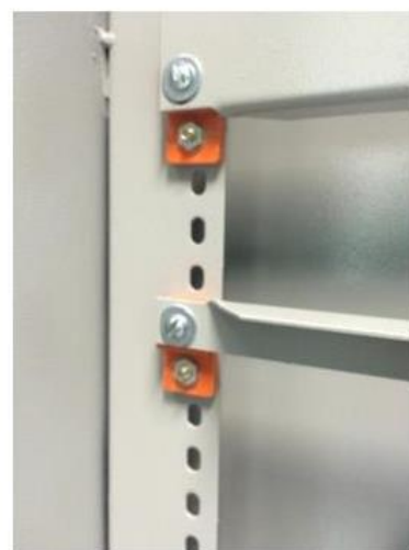
Figura 2: Detalhe da longarina e aplicação dos isoladores
