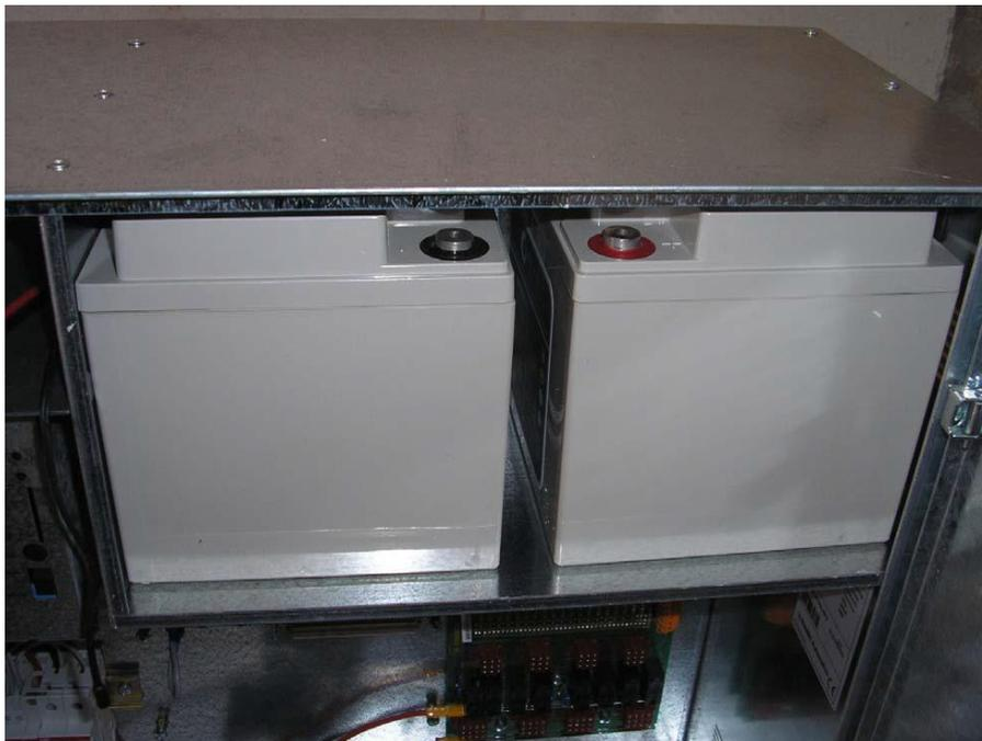
Figura n°3– Instalación de las baterías dentro de la UP
